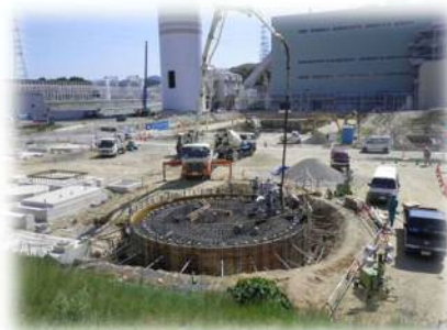
▲ コンクリート打設
