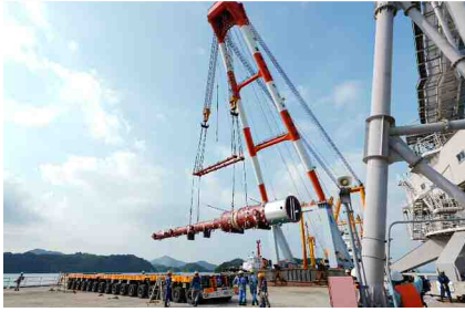
① 栈橋でクレーンを使って水切りします。
