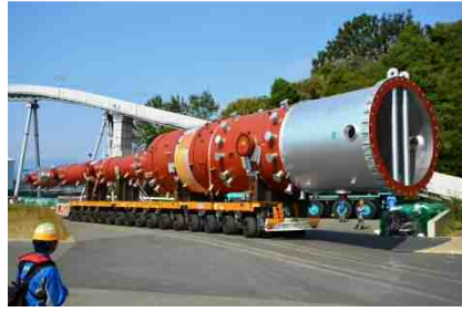
② トランスポーターに載せて運びます。
