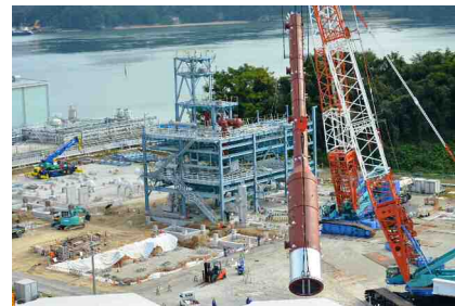
⑤ 大型クレーンを巧みに操作して胴体を起します。
