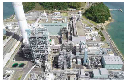
上空から見た IGCC 設備
