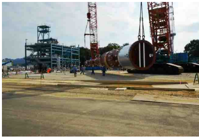
④ 2 台の大型クレーンで持ち上げます。
