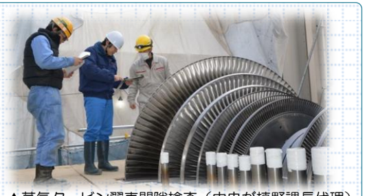
▲蒸気タービン翼車間隙検査（中央が榎野課長代理）
