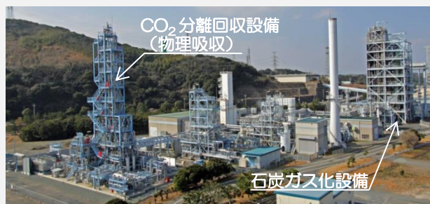
J-POWER 若松研究所の実証試験プラント（福岡県北九州市）
