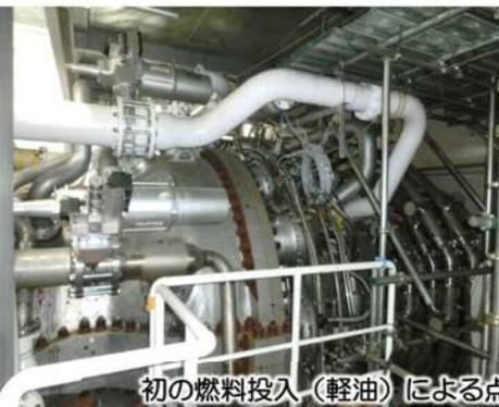
初の燃料投入（軽油）による点火試験、制御室と現場は緊迫感に包まれた
