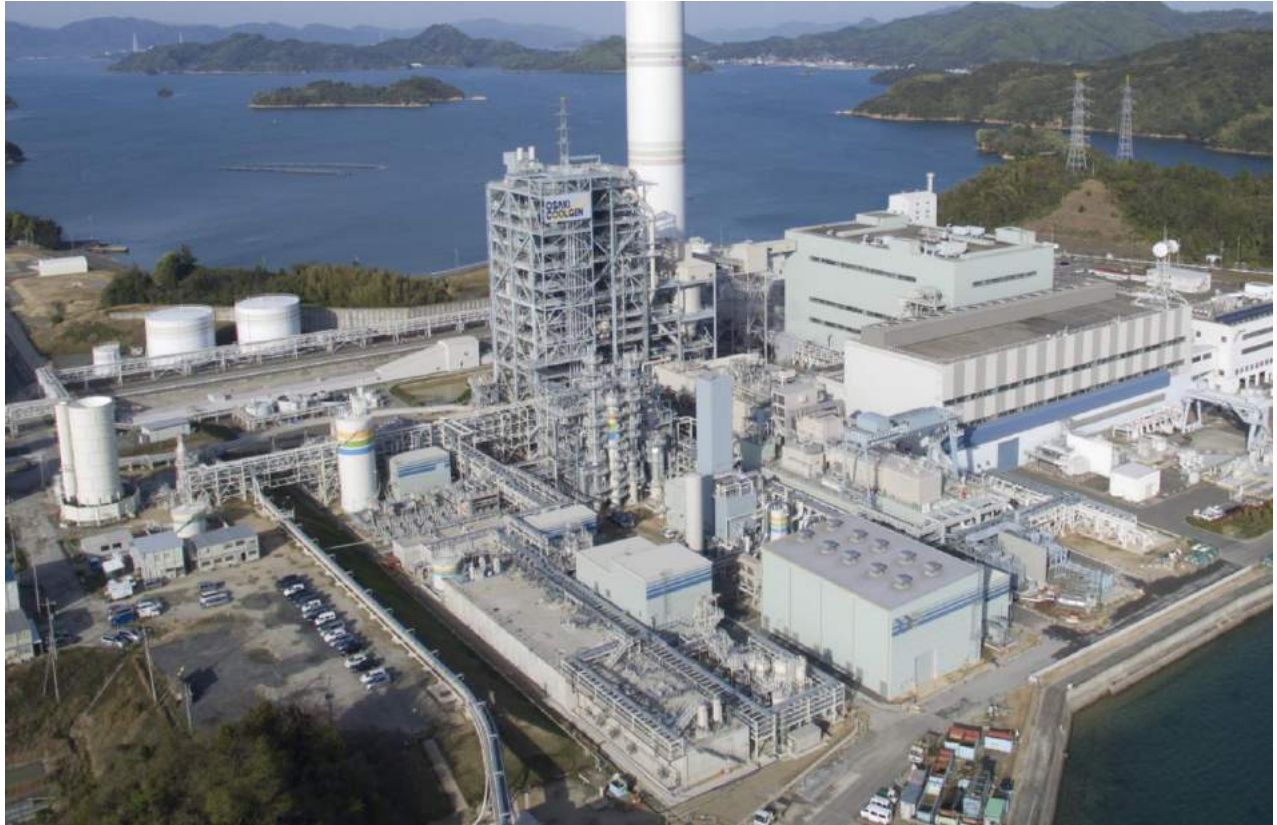
図2 酸素吹IGCC実証試験発電所(中国電力㈱大崎発電所構内)
