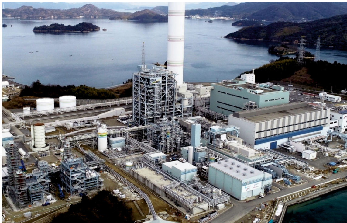
図1 第1段階の実証試験を完了した酸素吹 IGCC 実証試験発電所（中国電力㈱大崎発電所構内）
