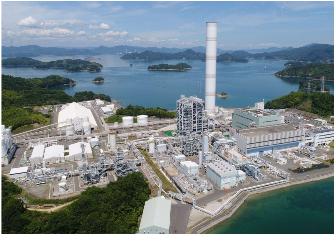
図3 実証試験プラント全景(広島県豊田郡大崎上島町、中国電力株式会社大崎発電所内)
